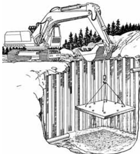
Рис. 42 Опускание фундаментной плиты
