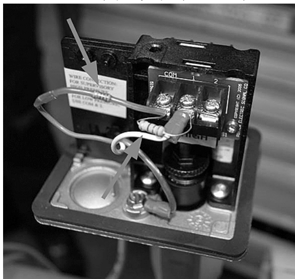
7-сур. Қысым релесінің корпусындағы кедергілерді (резисторларды) орнату мысалы
