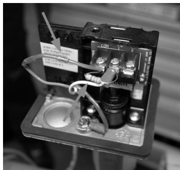
Рис. 3 Пример установки сопротивлений (резисторов) в корпусе реле давления
