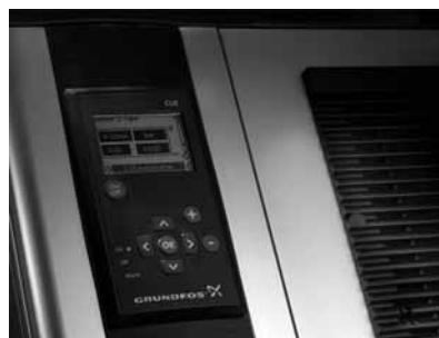
Рис. 91 Панель управления Grundfos CUE
